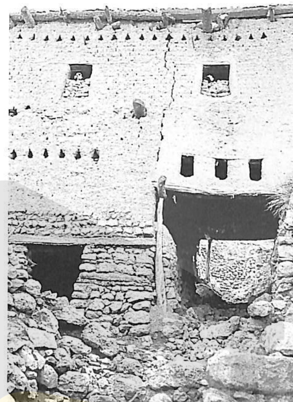
Beni Souik. Maison à plusieurs niveaux avec petits trous d'aération pour les pièces de réserve hautes. Sous la maison s'ouvrent deux passages, un pour la circulation des hommes et des animaux, et un autre, plus petit, pour l'écoulement des eaux.
