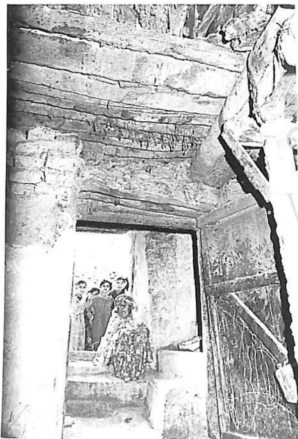
Beni Souik. Seuil et sqiffa vus depuis l'intérieur de la pièce centrale située légèrement en contrebas.
